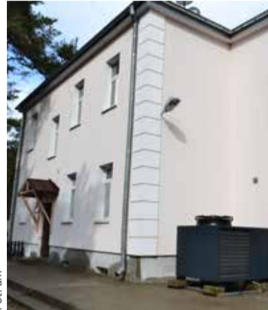
Budynek komunalny przy ul. Patriotów wyposażony jest w pompę ciepła
